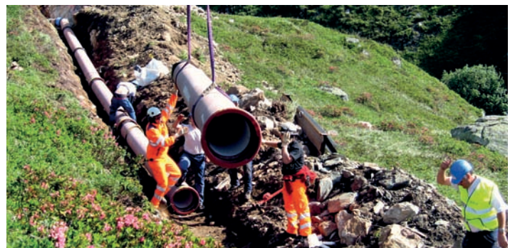
Verlegung im alpinen Gelände
