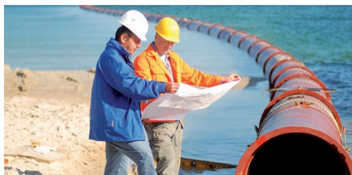
Einschwimmen einer duktilen Gussrohrleitung
