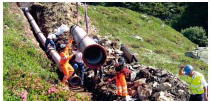
Verlegung im alpinen Gelände
