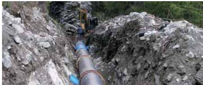
BIT-Rohr in unwegsamem Gelände
