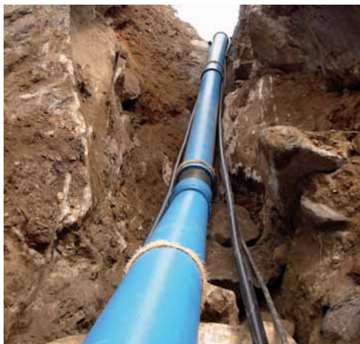
Rohr im Felschlag verlegt
