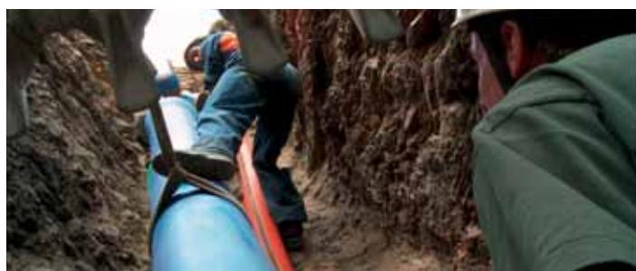
Steilhangverlegung mit bis zu 85° Neigung
