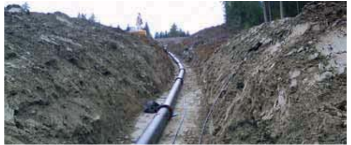
Abwinkelbar bis 5°, spart Zeit und Formstücke
