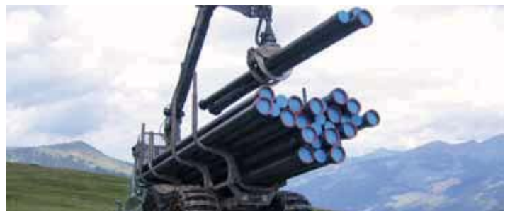
Antransport mit Spezial-Gerät – Bergbahnen AG Kitzbühel, Österreich
