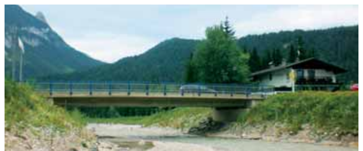
Hochwasserschutz Leutascher Ache – Österreich – Ökologische Aufwertung des Flußabschnittes
