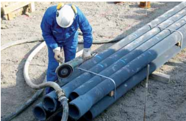
Der erste Rohrschuss wird mit einem Einschnitt für den Betonaustritt versehen
