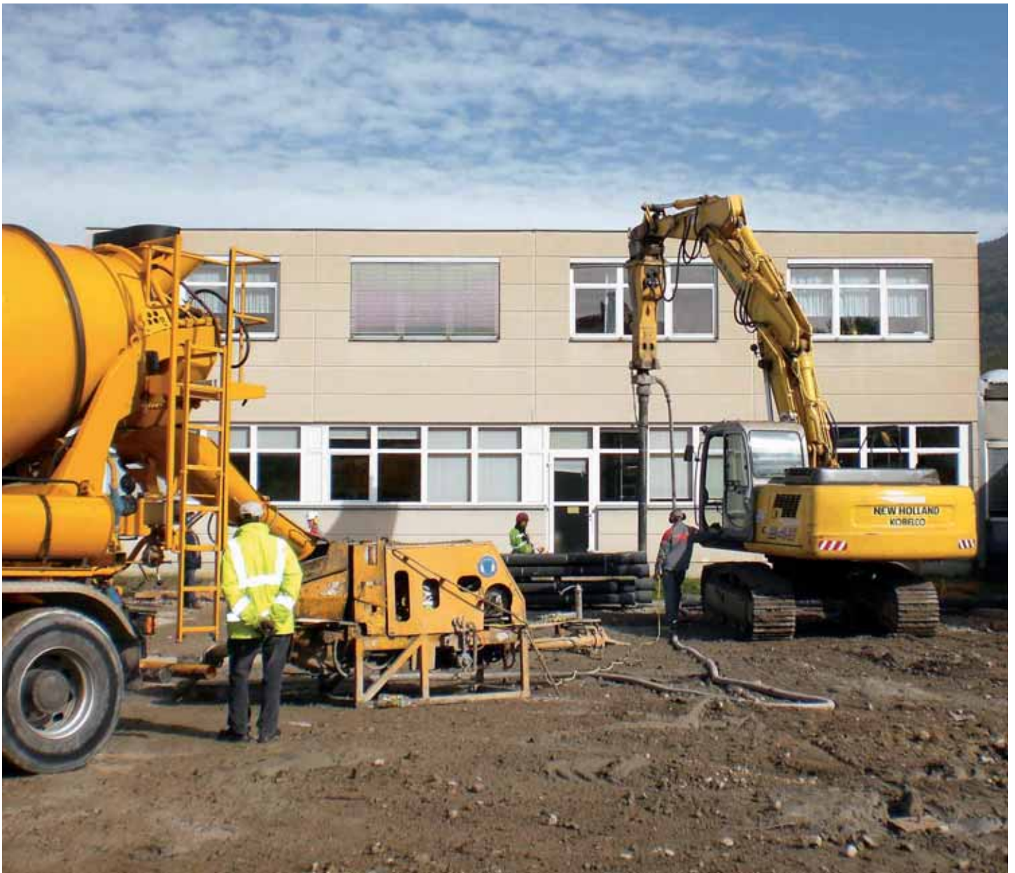
Werkerweiterung in der Innenstadt von Salzburg – Österreich, mantelverpresste duktile Gussrammpfähle mit einer Länge bis zu 59 m tragen Lasten von 800 kN ab
