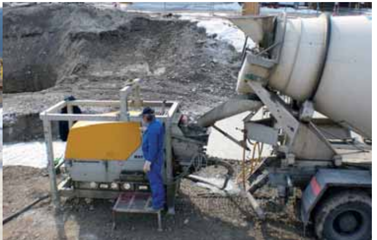
Die Verpressung erfolgt gleichzeitig mit dem Einbau des Pfahles
