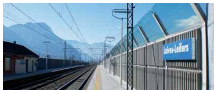
Lärmschutzwände Brennerachse – Italien, 4,5 km Eisenbahnstrecke
