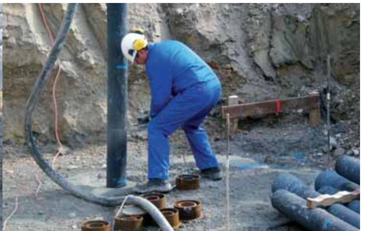
Der Überstand wird auf planliche Höhe abgetrennt und als Anfangsstück für den nächsten Pfahl weiterverwendet
