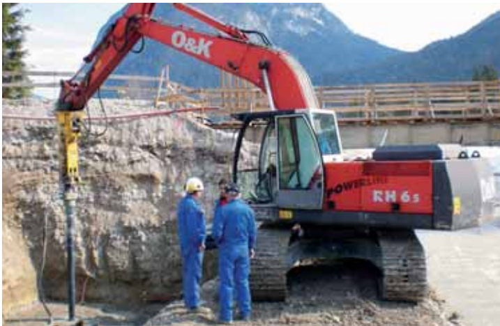
Nachweis der äußeren Tragfähigkeit während der Herstellung
