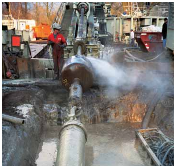
Horizontales Spülbohrverfahren
