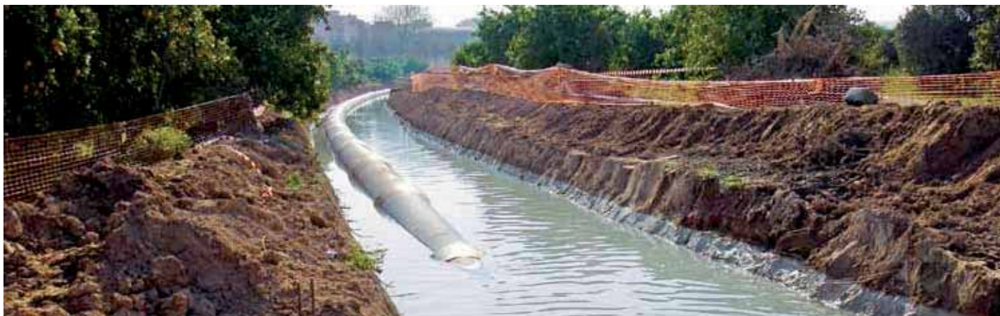
Spülbohrdüker DN 900 in Valencia – Spanien
