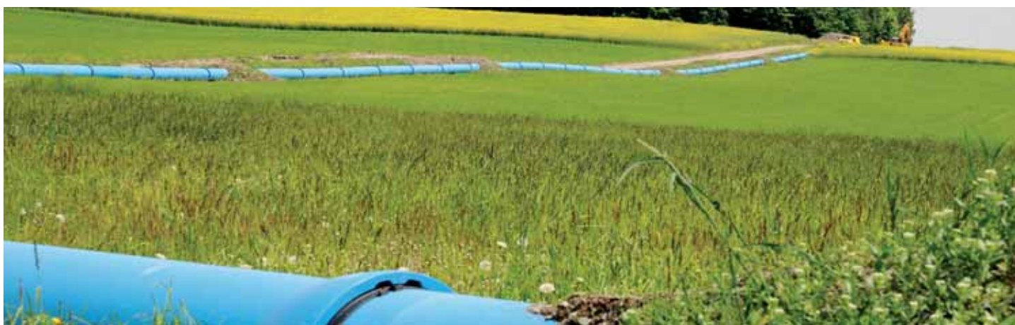
„Fliegende Leitung“: Hartenstein DN 600
