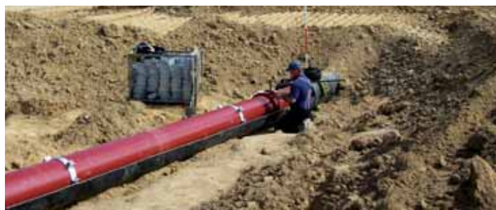
Einschub duktiler Gussrohre DN 400 mit BLS®-/VRS®-T-Steckmuffen-Verbindung in eine Schutzrohrstrecke
