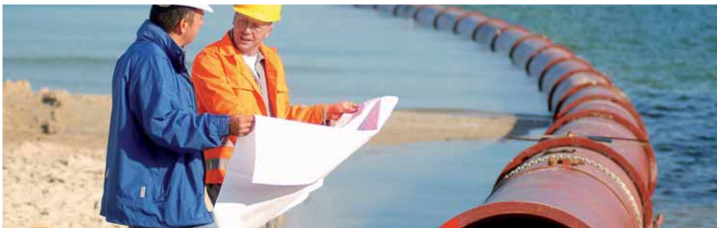
Einschwimmen: Binz/Rügen DN 1000
