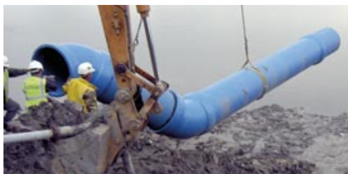
Verlegepraktiken auf der Baustelle
