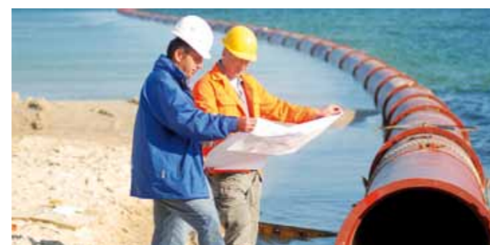
Einschwimmen einer duktilen Gussrohrleitung
