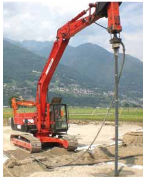
145 verpresste duktile Pfähle geben dem Fundament Stabilität
