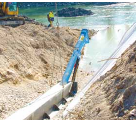
Um das Aufschwimmen der Leitung zu verhindern, war eine Betonummantelung nötig
