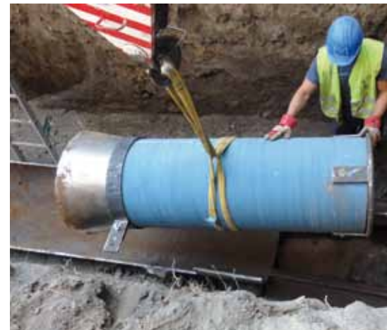
Einbringen des Duktus-Zugkopfs in die Stahlrohrleitung
