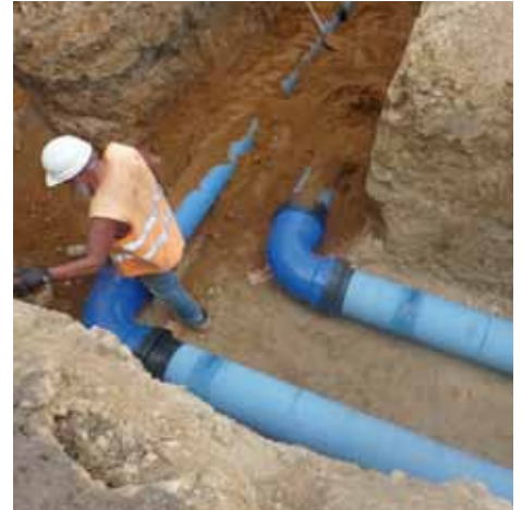
Für die Löschleitungen im Škoda-Werk wurden 190 Meter ZMU-Rohre verlegt
