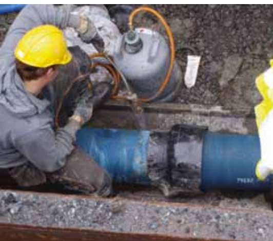
Rohrmontage vor dem Einzug der DN 250 -Rohre
