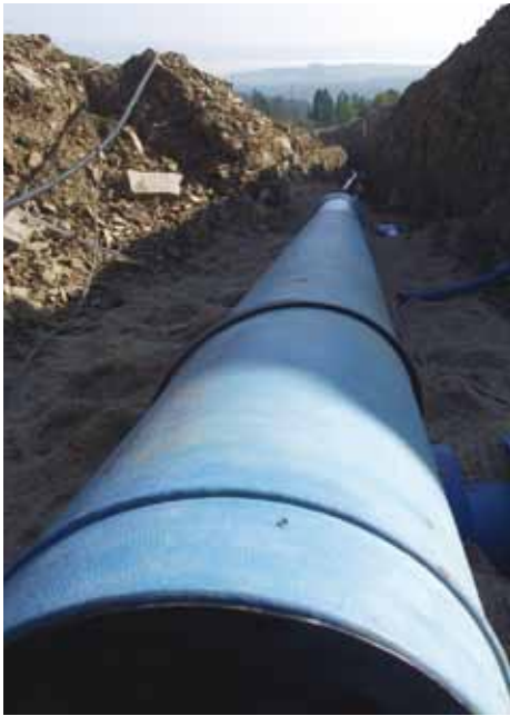
Im polnischen Skiresort Bania Kotelnica werden 4,5 Kilometer duktile Gussrohre 25 Schneekanonen mit Wasser versorgen
