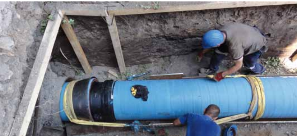
Auch DN 600 Rohre lassen sich sehr leicht mit Kettenzügen auf engstem Raum installieren
