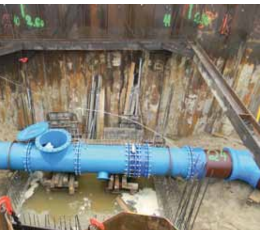
Führung der Gussrohrleitung DN 600 durch das Schachtbauwerk
