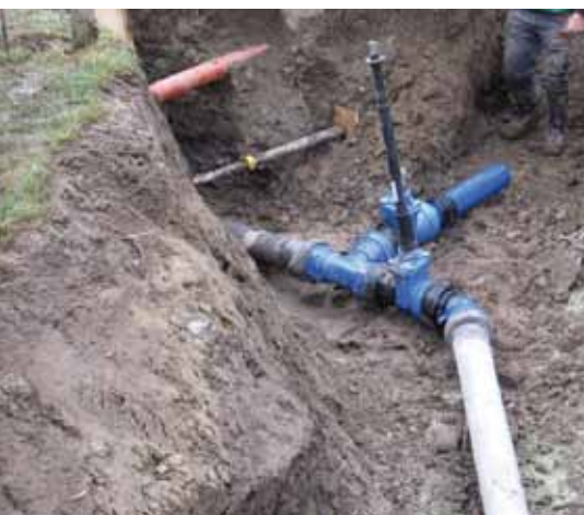
Eine 650 Meter lange Hydrantenleitung aus Duktus-Rohren DN 125 sorgt für ausreichende Löschwasserkapazität
