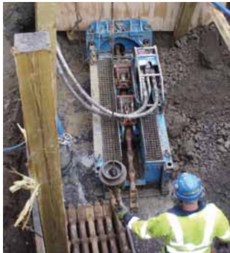
Berstlining-Baustelle im finnischen Tampere: Einzug des Berstgestänges in der Startgrube
