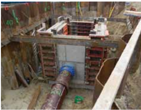
Einbindung der duktilen Gussrohre im Schachtbauwerk
