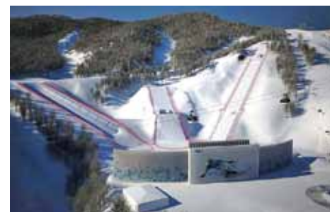
Snowboard-Park und Freestyle-Skizentrum in Rosa Khutor; hier sorgen 16 Kilometer Duktus-Rohre für die sichere Wasserzuleitung zu den Schneekanonen
