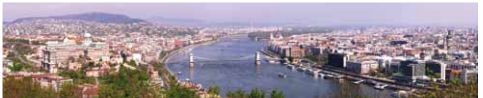
In Ungarns Hauptstadt Budapest wurde erstmals die grabenlose Verlegung im Relining-Verfahren mit Duktus-Rohren durchgeführt
