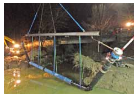
Arbeiten unter Flutlicht
