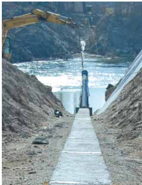
Auf einer Länge von 92 Metern wird die Dükerleitung aus Duktus-ZMU-Rohren in die Traun eingebracht
