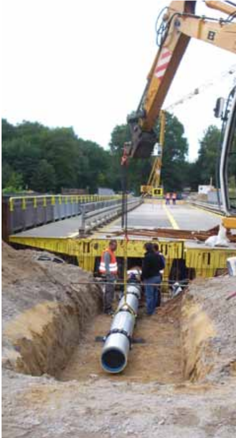
Montage und Einzug der WKG-Rohre
