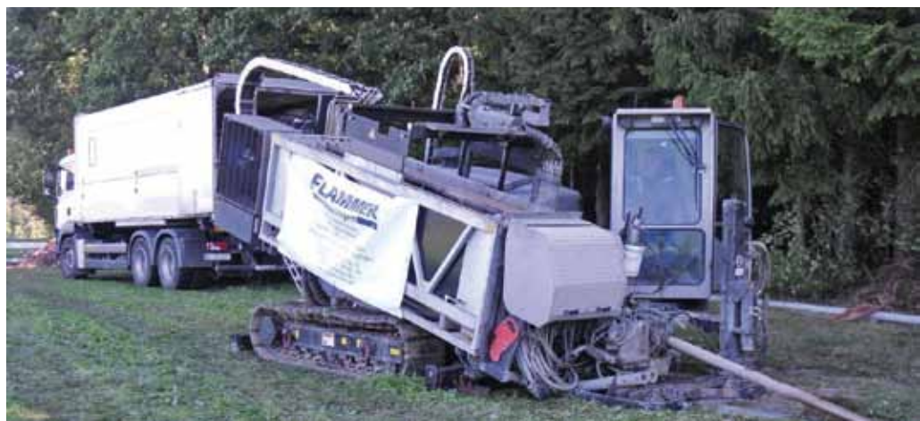
Ein 200 Meter langer Teilabschnitt der zukünftigen Anschlussleitung an den Hochbehälter Zavelstein wurde im Spülbohrverfahren ausgeführt. Hier wurde eine alte Asbestzementleitung ausgetauscht
