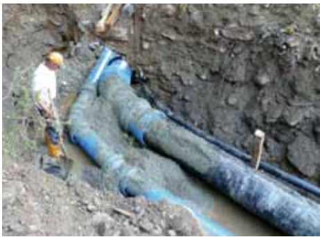
Mehr als 40 Muffenbögen waren für die Ausführung der Turbinen- und der Beregnungsleitung in Albeins notwendig
