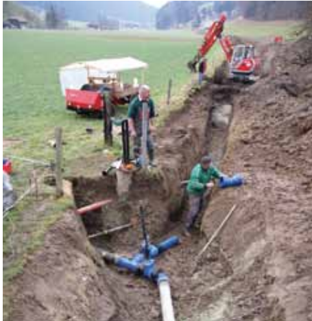
Verlegung der Hydrantenleitung auf der Emmentaler Sonnhalde
