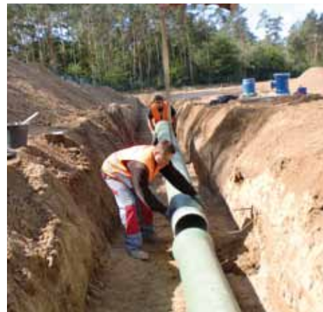
Für die Erschließung der Betriebsbereichserweiterung im Südwesten des Frankfurter Flughafens liefert Duktus u.a. 1.680 Meter Brauchwasserrohre mit grünem Außenanstrich
