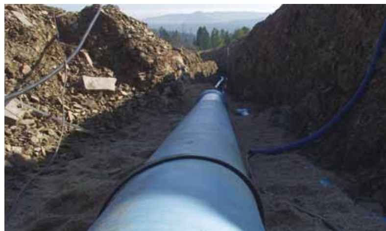
Im polnischen Skiresort Bania Kotelnica werden 4,5 Kilometer duktile Gussrohre 25 Schneekanonen mit Wasser versorgen
