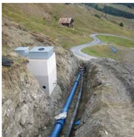
Obersaxen Mundaun: 20 Kilometer optimal verlegt – mit duktilen Gussrohren und der BLS®/VRS®-T-Schubsicherung von Duktus
